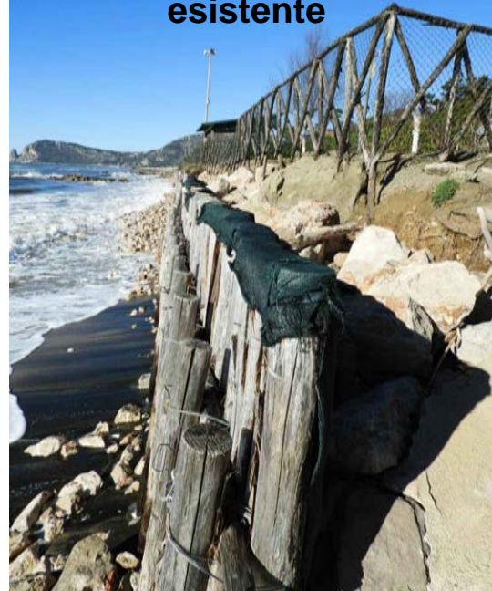
Tratto di palificata ancora esistente
